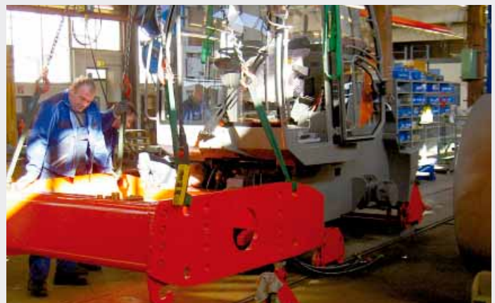
Montage der Walzenzüge, die weltweit begehrt sind.
